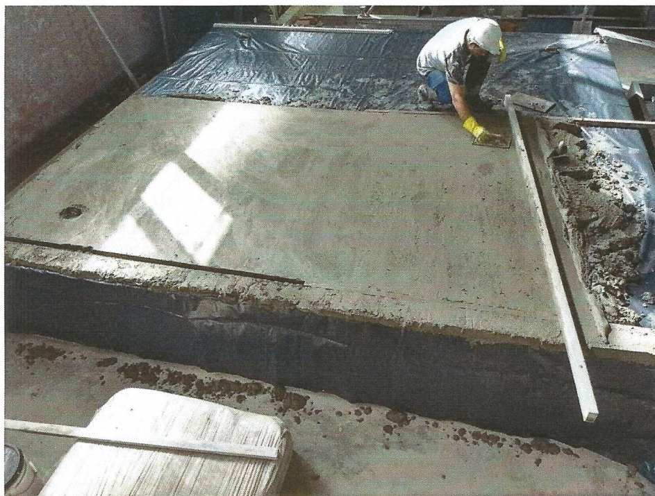
Figura – Montagem do sistema construtivo
