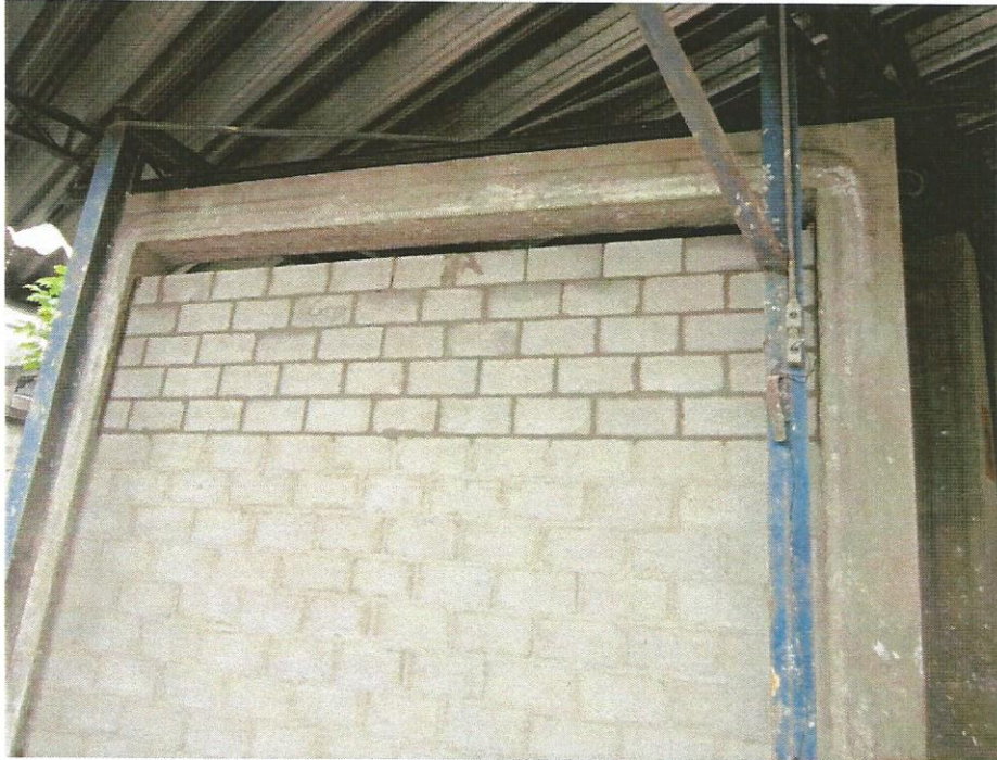
Foto 1: Montagem da parede de blocos de concreto
